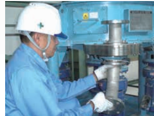
①空送配管取り外し作業 付属配管等の取り外しを行っています。
