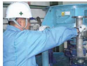
⑦増締めチェック作業 増締めを行いボルトの緩みがないか確認を行っています。
