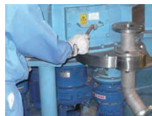
⑨タッチアップ作業 機器より錆等が発生しない様、タッチアップを行っています。
